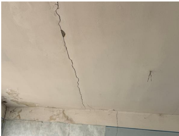
Նկ. 10 Ծածկերի սալերի միջև կարանների ուղղությամբ առաստաղի սվաղում առկա ճաքերի տեսքերը
