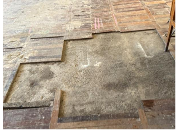
Նկ. 8 Հատակների, դռների ու պատուհանների և ներքին հարդարման վնասվածքների տեսքերը
