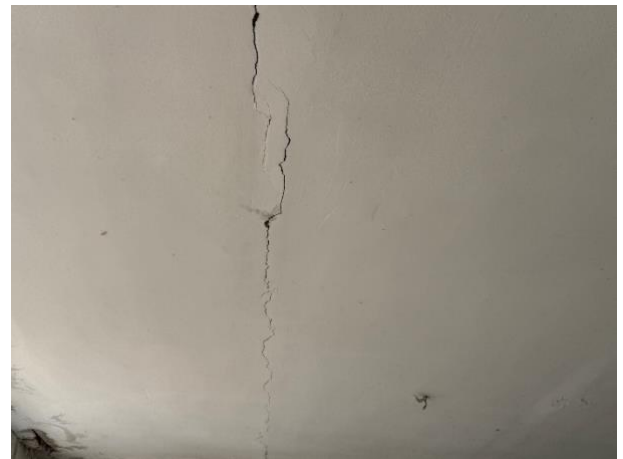
Նկ. 10 Ծածկերի սալերի միջև կարանների ուղղությամբ առաստաղի սվաղում առկա ճաքերի տեսքերը
